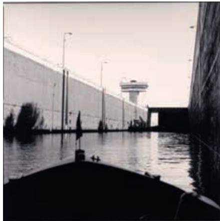
Schleuse Iffezheim Km 334
