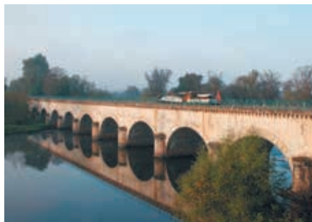
Kanalbrücke über die Loire bei Digoin
