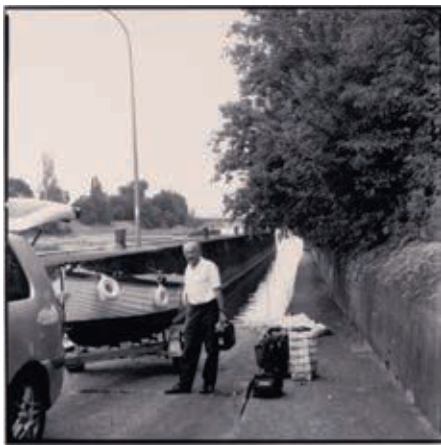
Einwasserung Kraftwerk Birsfelden
