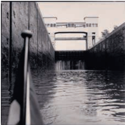
Schleuse Kembs Km 179
