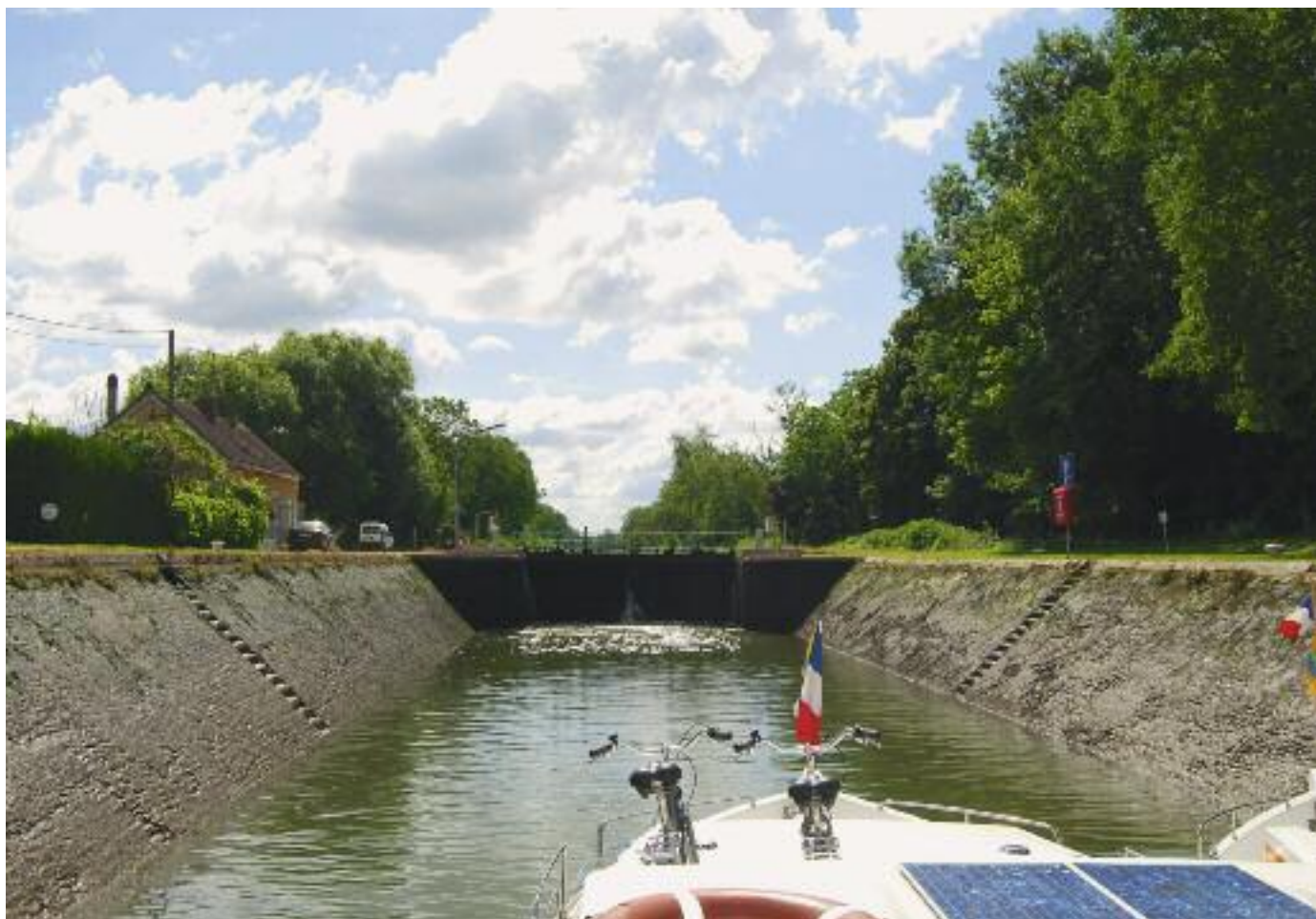
Die letzte «schräge» Schleuse vor Joigny
