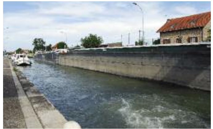
Lastkahn und nicht Schleusenmauer (Schleusenrösse 180 m x 11,4 m)
