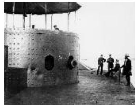
USS MONITOR 1862, Geschützturm (Quelle: Wikipedia)
