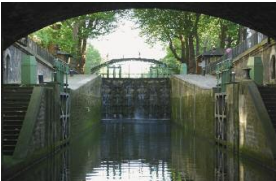
Gleich nach dem Tunnel unter der Bastille die erste Doppelschleuse des Canal St.Martin
