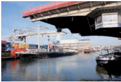
Westquai, der rückgebaut und dann mit «Rheinhatten» überbaut wird. Vorne: Hafenbecken 1, das nach dem Rückbau der Hafenbahn verlängert wird
