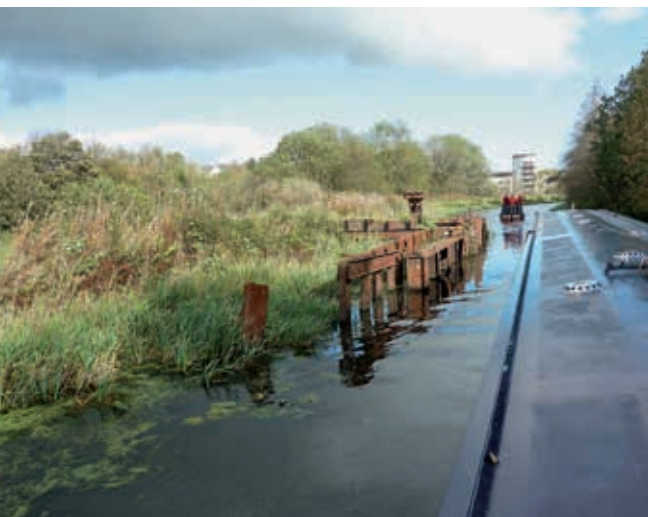
Mehrere einfache Schleusentore wurden eingebaut, um das ganze Auslaufen des Kanals bei Bombenschäden zu verhindern
