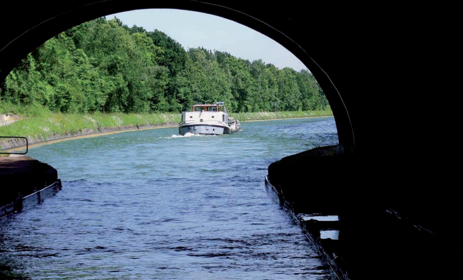
Tunnelfahrt nach 4354 m
