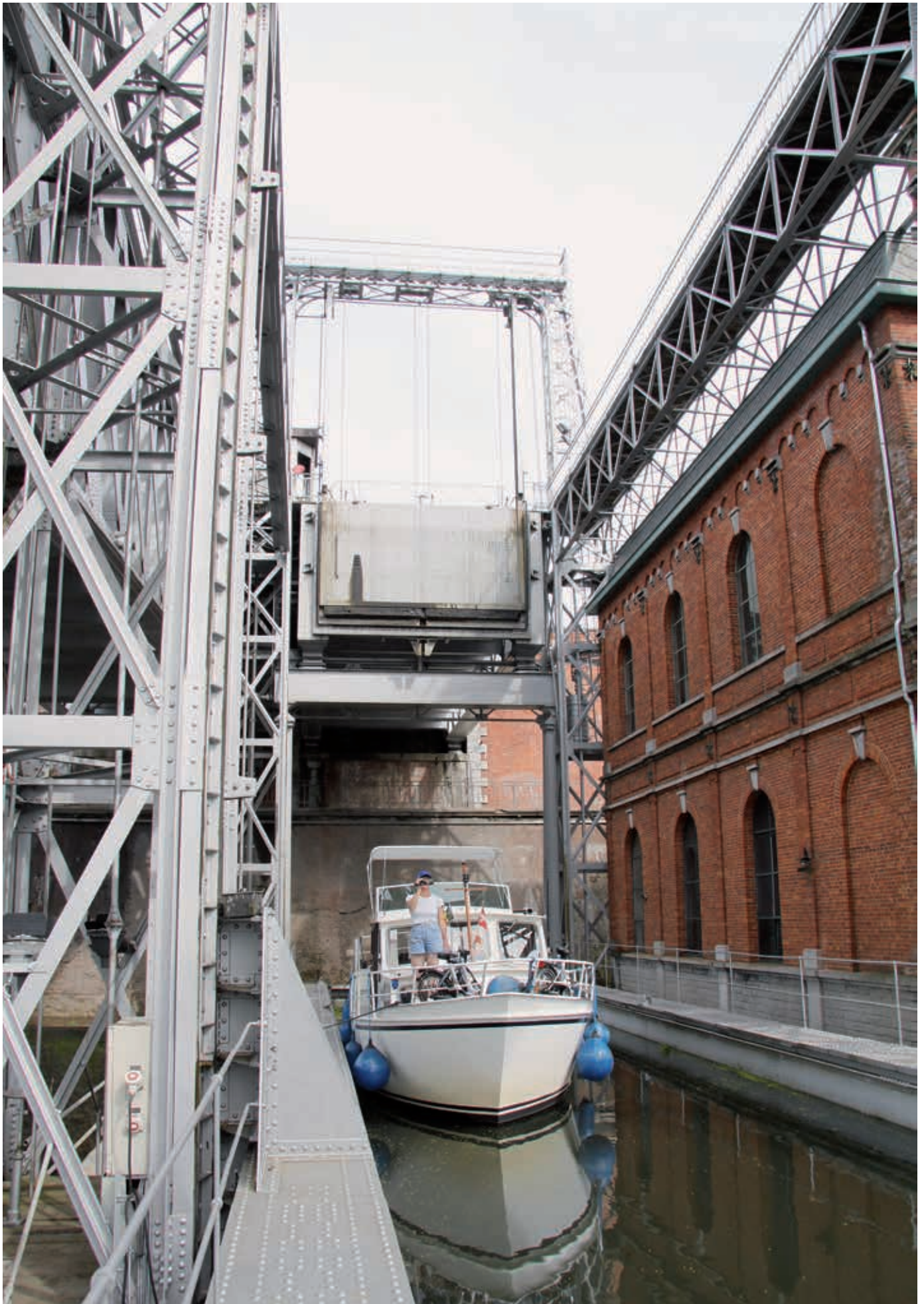
Das erste der vier Hebewerke im Canal historique...
