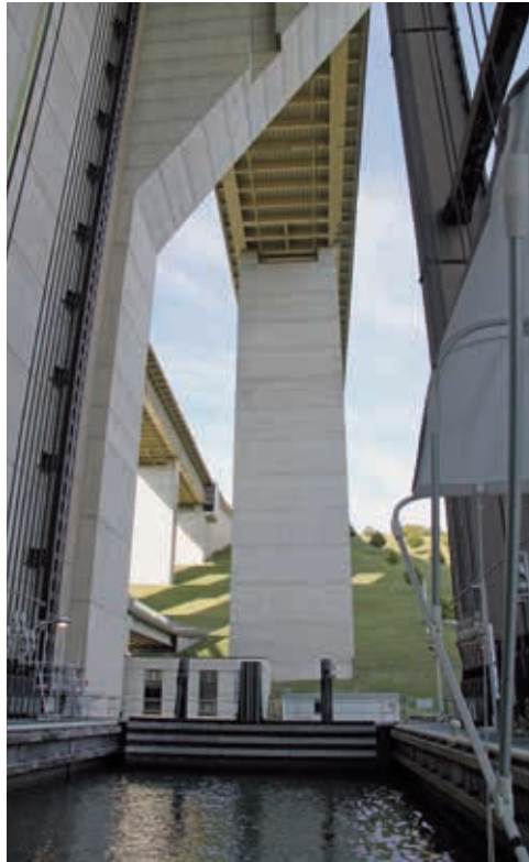
In wenigen Minuten 73,15 Meter in die Tiefe
