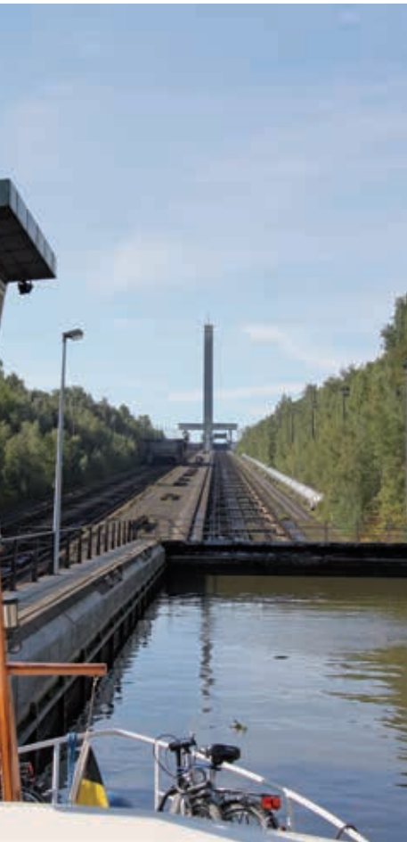
Auf vier Schienen die 1,5 km lange, schiefe Ebene hinauf
