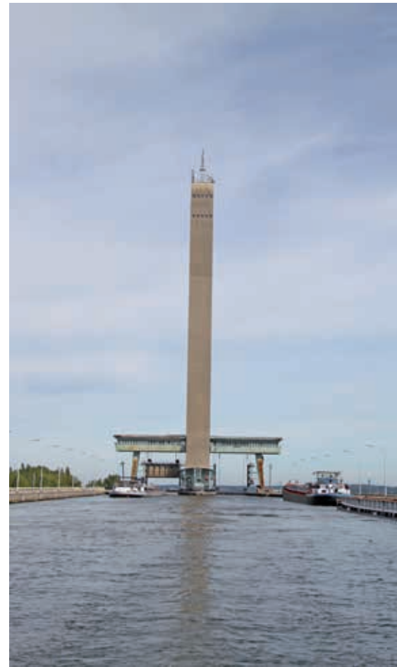
Nach rund 20 Minuten 68 Meter höher
