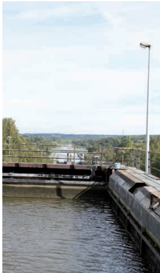
In der 12 Meter breiten und 84 Meter langen Wanne
