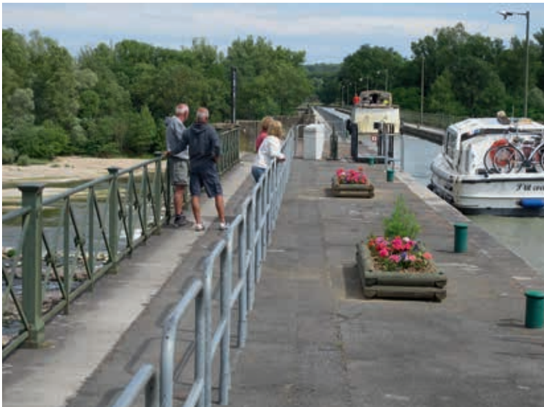
Im Kanal über den Fluss
