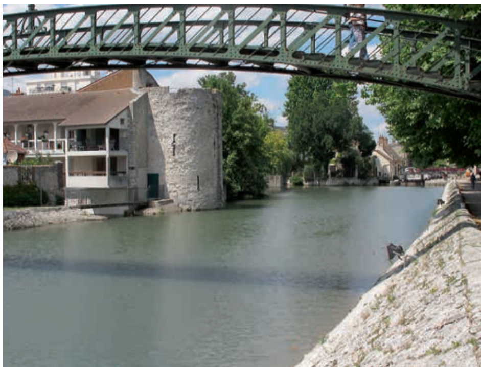
Elegante Fussgängerbrücke in Montargis
