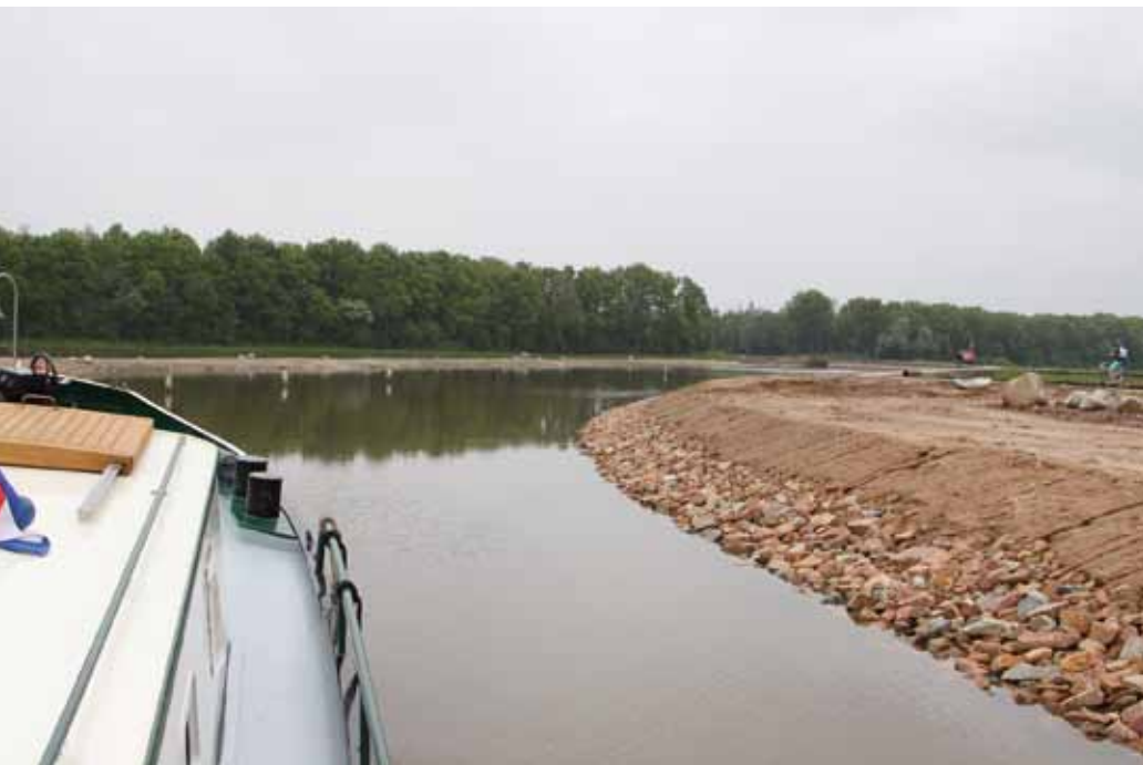
Soeben fertig gestelltes Teilstück
