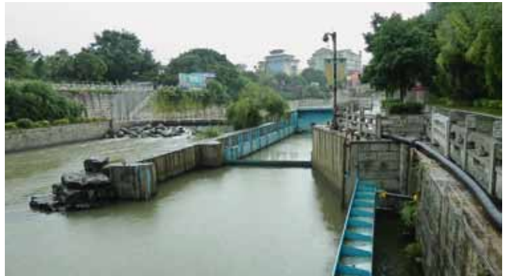
Echte moderne Schleuse in Guilin, die von einem Nebenfluss in den Fluss Li führt. Sie ist leider nicht in Betrieb, war vielleicht schon lange nicht mehr.
