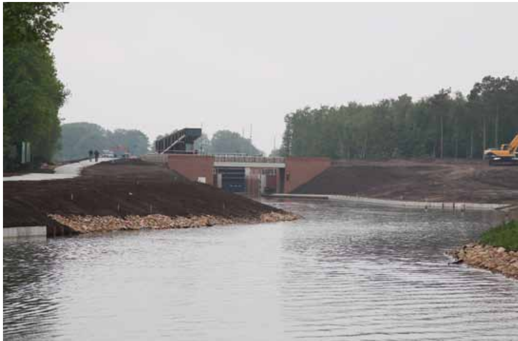
Im Unterwasser der neuen Doppelschleuse
