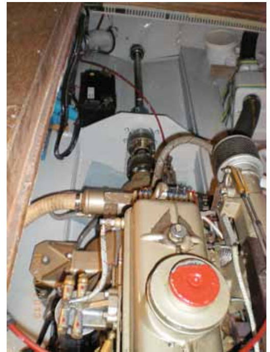
Maschinenraum der Escape. «Wenn man im Motorraum essen kann, sagt das etwas über den Eigner aus».
