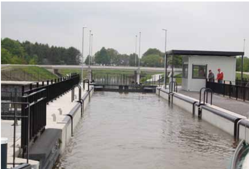
In der Sparschleuse
