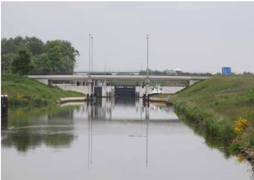
Die neue «Sparschleuse»
