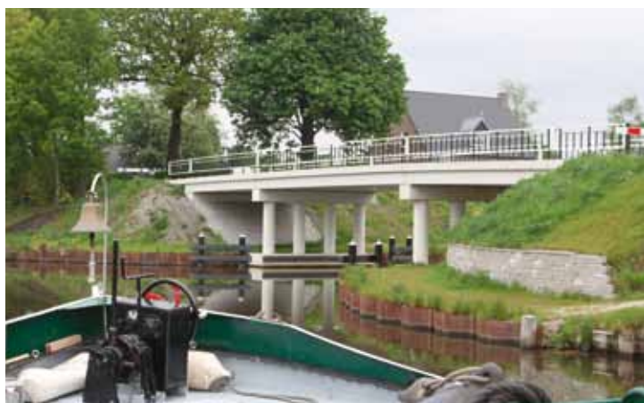
Einfahrt in den neu gegrabenen Kanal
