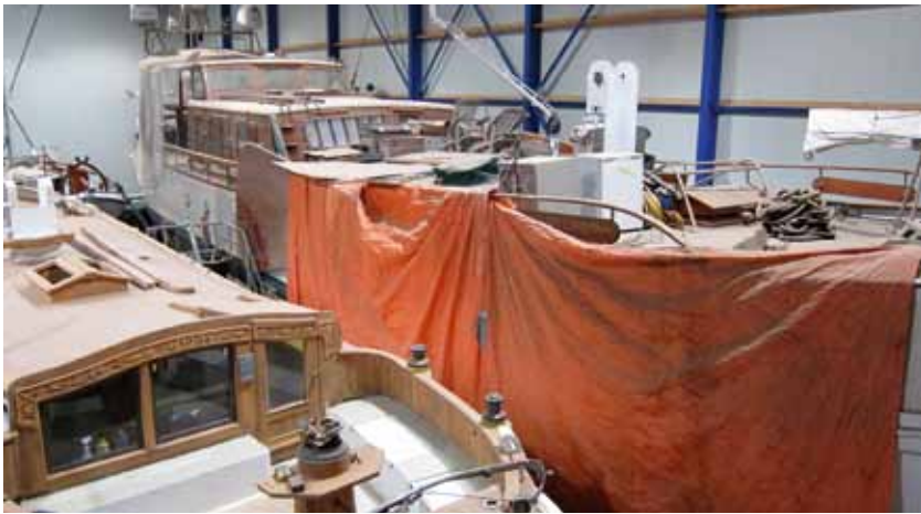
Wohnräume werden wahr bei Scheepsreparatie Friesland (SRF) in Harlingen
