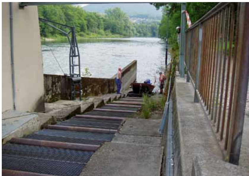
4 Das Boot wird über die Rollen mit dem Schlitten hoch gezogen. Es ist schmäler als die zulässige Breite und würde ohne Schlitten bereits an den Treppenstufen anstehen.
