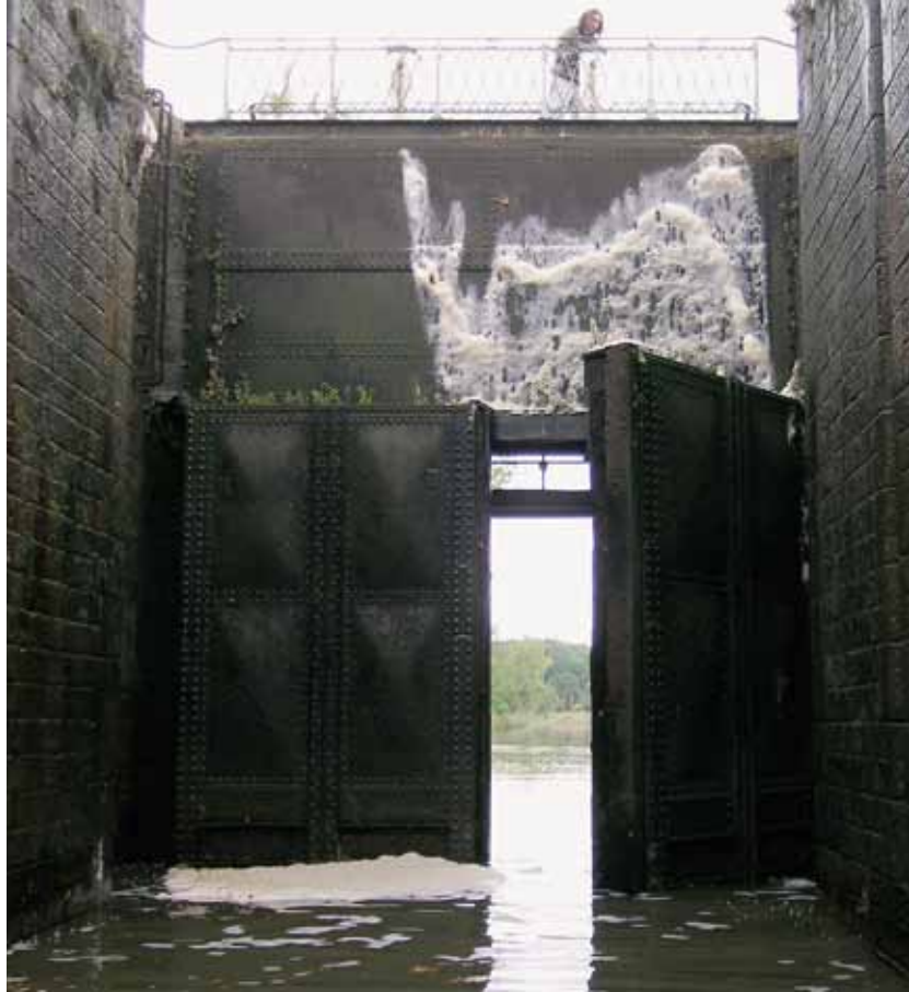
Die Schleuse Bourg le Comte mit 7.2 m Hubhöhe wird geöffnet
