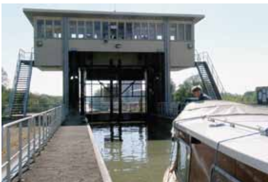
Die letzte Schleuse des Canal du Centre setzt mit einem Hub von nahezu 11 Metern einen würdigen Schlusspunkt
