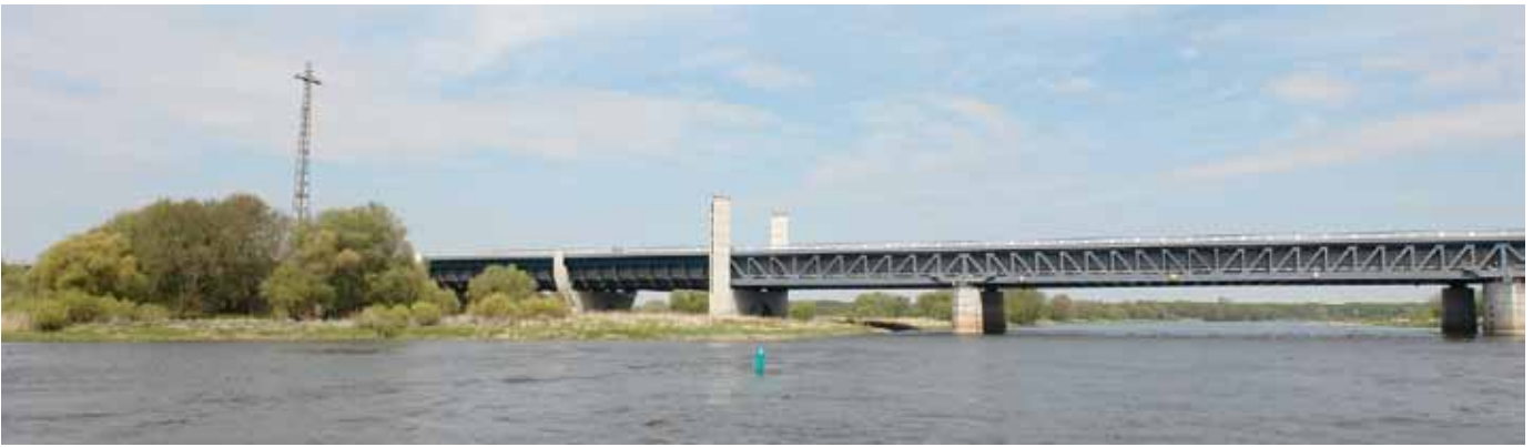
Mittellandkanal-Brücke über die Elbe bei Magdeburg
