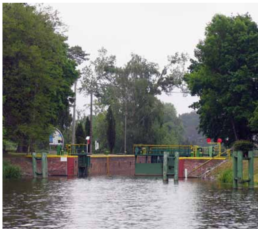
In dieser Region wird jeweils nur ein Schleusentor geöffnet
