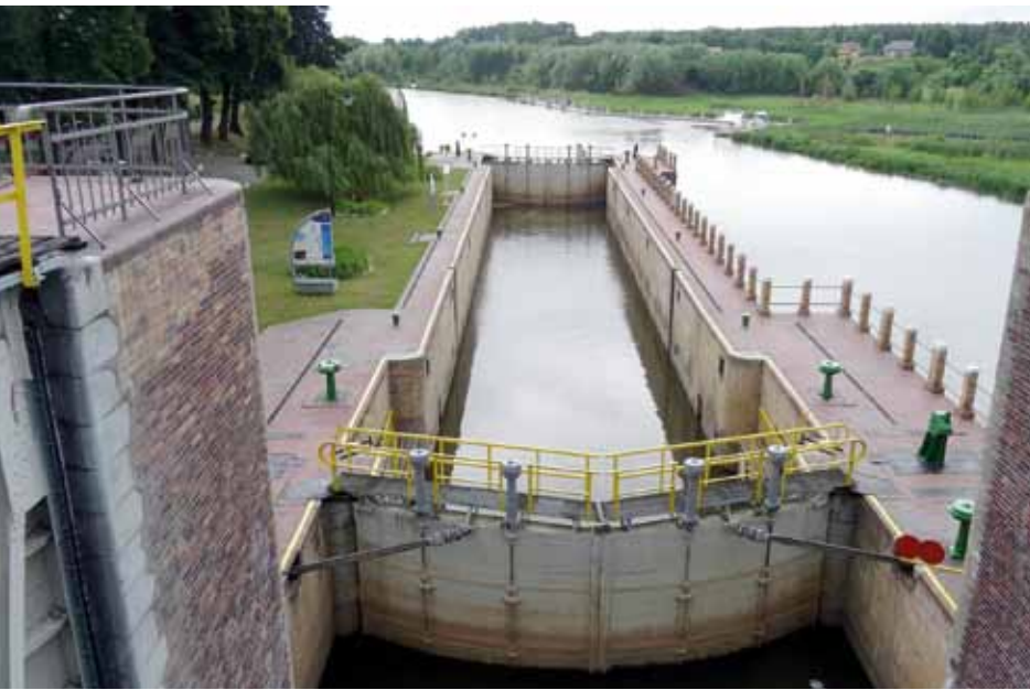
Die neue Schleuse von «Biała Góra» ermöglicht uns die Zufahrt zur Nogat ...
