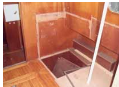
Hier kommt die neue Küche hin
