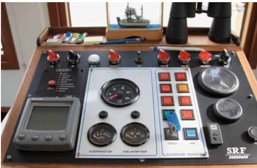
Das Armaturenbrett im Steuerhaus ...
