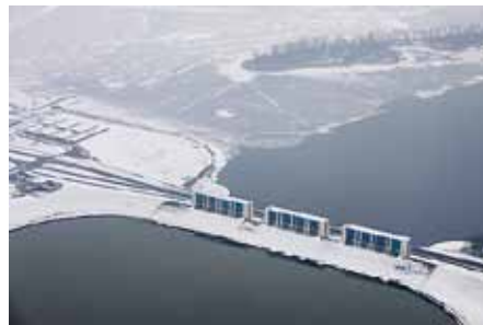
Der Bau des Abschlussdeichs mit den Spülschleusen kurz nach der Fertigstellung. Vom Dorf Lauwersoog und der aktuellen Situation ist noch nichts sichtbar.
