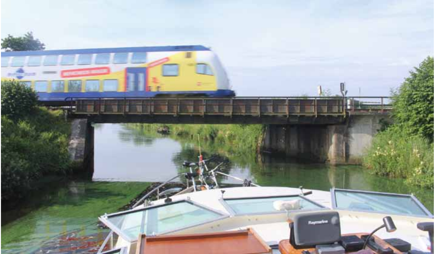
Niedrige Durchfahrtshöhe Eisenbahnbrücke
