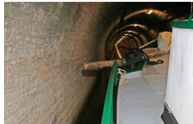
«Spurhalter» im Tunnel
