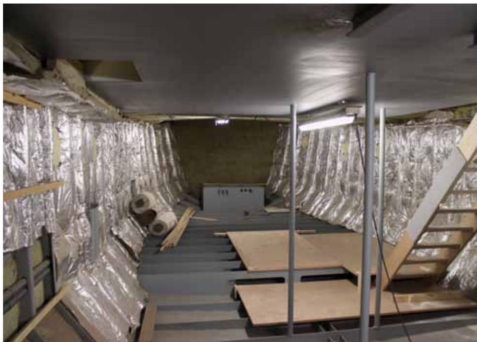
Nächstes Schleyschifferprojekt im Rohbau – innen
