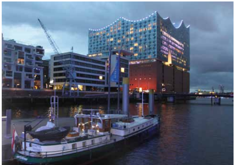
Liegeplatz zu Füßen der Elbphilharmonie
