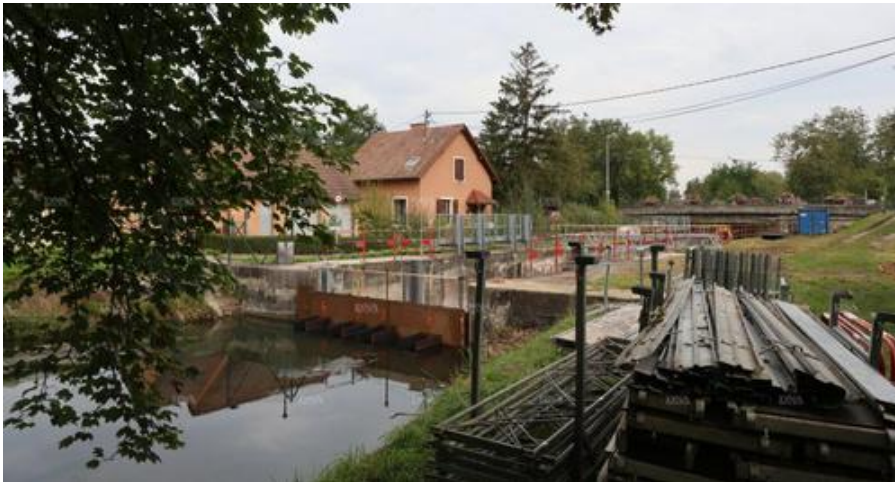
Les travaux de modernisation de l'écluse 66 à Marckolsheim sont suspendus depuis le 18 octobre. Photo Cédric Joubert
